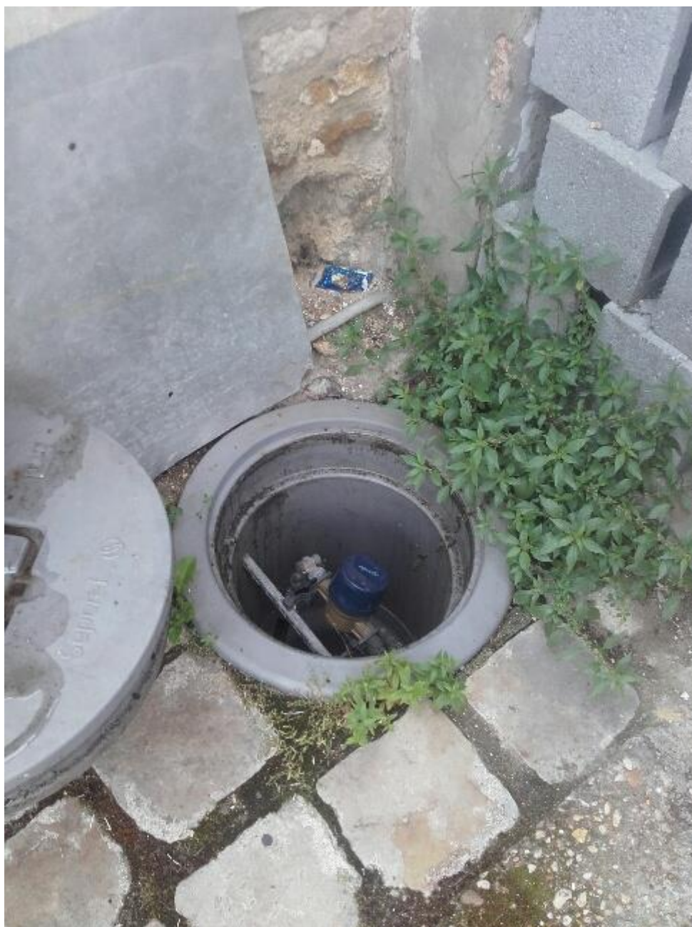
Figure 6 : compteur d'eau
