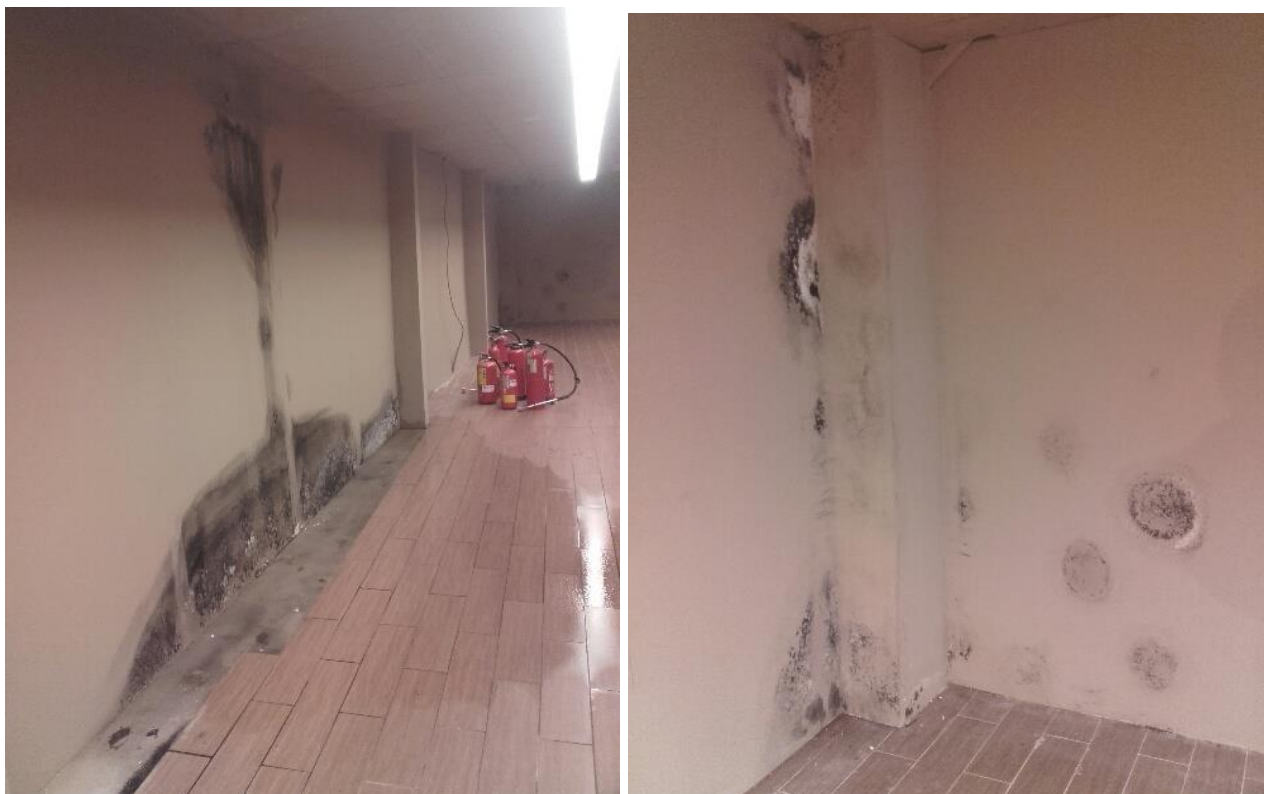
Figure 13 : Intérieur du local commercial traces de moisissures au mur et au sol et forte humidité au sol
