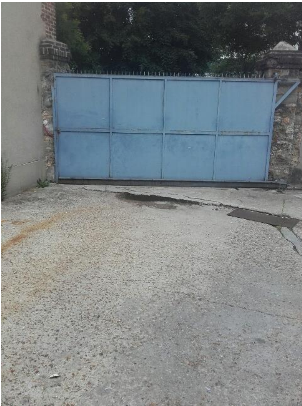
Figure 7 : Affaissement de la dalle béton à l'entrée du portail
