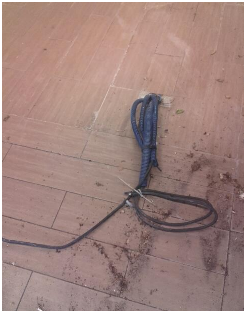
Figure 12 : réseau électrique passant sous dalle permettant l'alimentation électrique des anciennes caisses du supermarché
